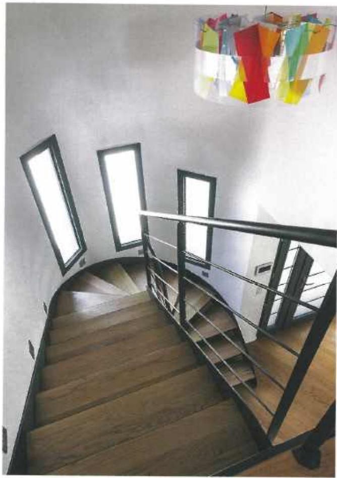
L'escalier 2/4 tournant est un petit chef d'œuvre... Les marches sont en chêne massif sur caisson et limon de tôle. Les parties métalliques sont recouvertes d'une laque bleue. Les poteaux de rambarde et le garde-corps de l'étage sont en fer plat. L'ensemble est léger, aérien, élégant.
