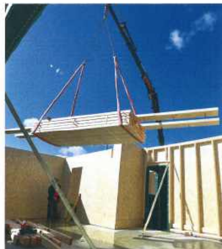
Assemblage « éclair » des panneaux montés à l'atelier.
