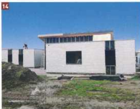
13 & 14 - Avec ses trois corps de bâtiments enchâssés, la maison présente une architecture originale. On observe ici le corps central recouvert du pare-pluie, tandis que le bardage est déjà fixé sur l'espace voisin.
