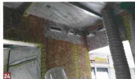
24 - Dans le mur de refend, c'est-à-dire le mur porteur intérieur, on a aménagé des passages de gaine VMC (ventilation mécanique contrôlée). Car pour raison technique, les murs de refend n'ont pas pu être intégrés au volume étanche à l'air. L'air extérieur circule donc dans le mur, ce qui oblige à traiter la perméabilité à l'air de la maison à chaque traversée des gaines VMC.
