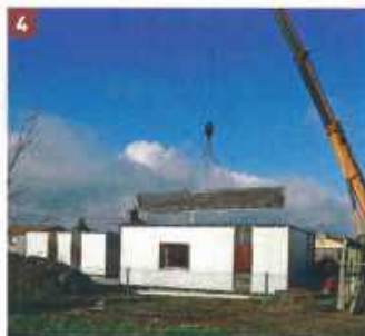
4 & 5 - Le montage de la maison peut démarrer. Les murs et la charpente sont livrés sur le chantier par le charpentier, qui les a fabriqués en atelier selon les plans de l'architecte. Certains panneaux sont déjà dotés de leur parement et sont prêts à être installés.
