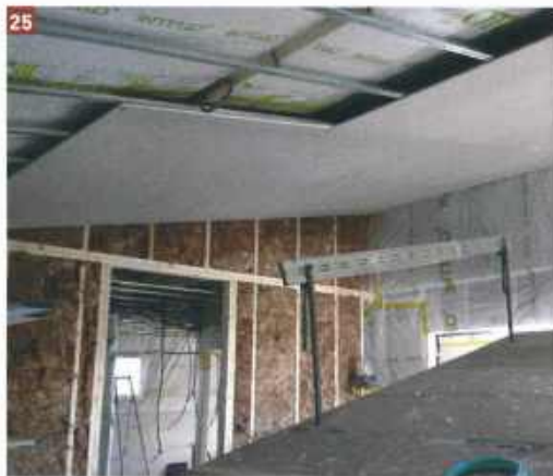
25 & 26 - Le railage a été mis en place au plafond et sur les murs intérieurs : le plaquiste commence à poser les plaques de plâtre au plafond.
