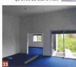
33 - Une moquette de chantier, à été posée afin de protéger le carrelage d'ici à la fin des travaux.
