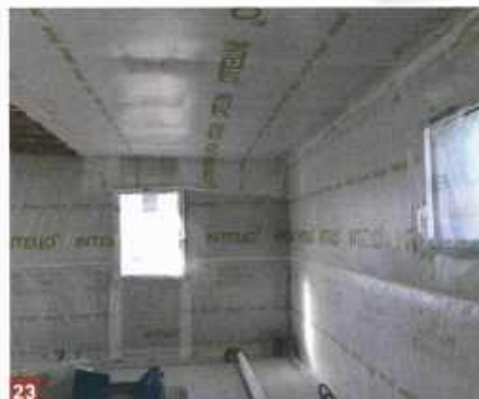
23 - Il est temps de procéder à l'étanchéité à l'air. Le plaquiste démarre la pose du frein-vapeur, qui permet d'assurer une bonne perméabilité à l'air de la maison.
