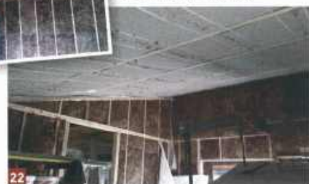
21 & 22 - L'isolation est en cours de pose. Pour les murs, l'architecte a opté pour 18 cm de laine de verre tandis que le plafond est isolé grâce à 2X12 cm de ouate cellulosique en panneaux. Ce matériau écologique offre de bonnes performances pour l'isolation de la toiture, par laquelle s'échappe 20 à 30% de la chaleur.
