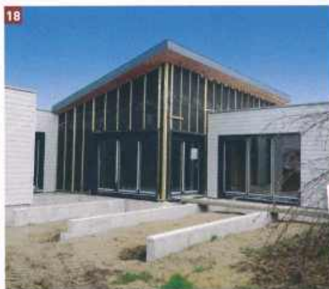
17 & 18 - La pose des menuiseries se poursuit. De grandes baies vitrées dans les pièces à vivre permettront d'optimiser les apports solaires, pour gagner en luminosité et réduire les coûts de chauffage en hiver.
