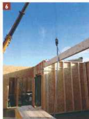
6 & 7 - On procède rapidement au montage des murs, pré-découpés pour s'ajuster directement sur place. L'essence d'épicéa, couramment employée dans la construction, a été retenue.
