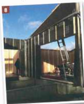
8 & 9 - Le pare-pluie a été appliqué sur les panneaux de bois. Son rôle est de former une enveloppe de protection pour la maison, face à l'humidité. Il sera plus tard recouvert du bardage.
