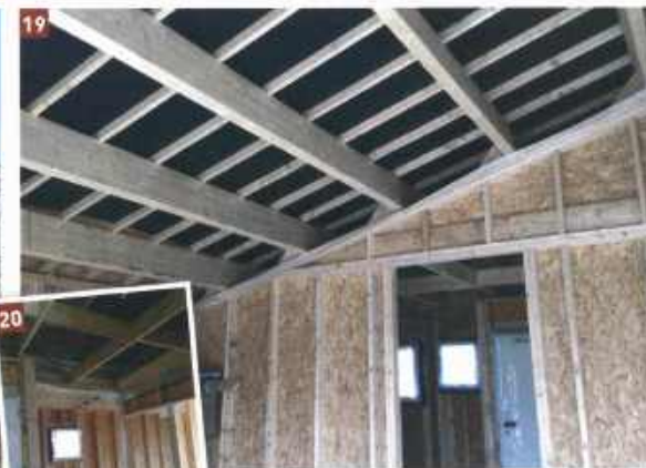
19 & 20 - Des bandes d'étanchéité à l'air ont été disposées par le charpentiers en anticipation du travail du plaquiste.
