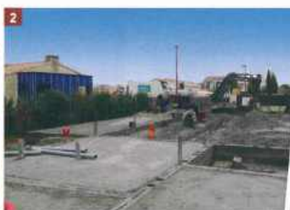
2 & 3 - Le terrassement est fait, sur un terrain ne présentant aucune complication particulière. Le maçon a monté les rangs de parpaings, installé les treillis puis a coulé la dalle en béton. Les câbles électriques et d'alimentation sont préparés.
