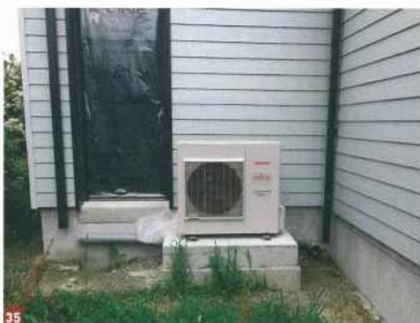
35 & 36 - La maison est dotée d'une pompe à chaleur double service (PAC) pour assurer la production du chauffage et de l'eau chaude sanitaire et l'on observe ici, l'unité extérieure du système. Une solution à la fois écologique et performante puisqu'elle consiste à récupérer les calories présentes dans l'air pour chauffer l'eau.
