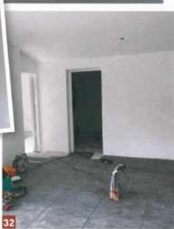
33 - Une moquette de chantier, à été posée afin de protéger le carrelage d'ici à la fin des travaux.
