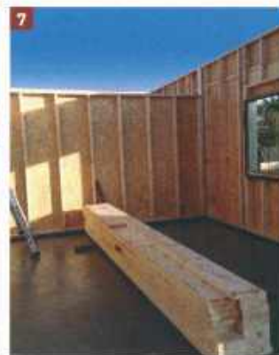
6 & 7 - On procède rapidement au montage des murs, pré-découpés pour s'ajuster directement sur place. L'essence d'épicéa, couramment employée dans la construction, a été retenue.
