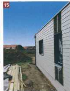
15 & 16 - Les ouvertures sont préparées à l'avance, dans les panneaux de bois. On procède maintenant à la pose des portes-fenêtres. Les pattes de fixations sont mises en place sur l'encadrement de bois.
