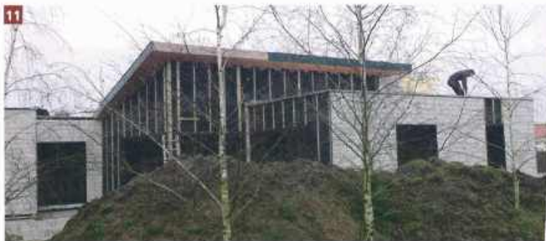
11 & 12 - La toiture terrasse est mise en place par le couvreur. Une toiture en zinc était initialement souhaitée par les propriétaires. Face au refus des services instructeurs, préférant une couverture en tuiles, l'architecte a proposé ce type de toiture permettant de dissimuler au mieux les tuiles.
