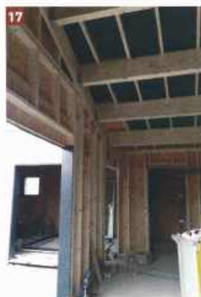
17 & 18 - La pose des menuiseries se poursuit. De grandes baies vitrées dans les pièces à vivre permettront d'optimiser les apports solaires, pour gagner en luminosité et réduire les coûts de chauffage en hiver.
