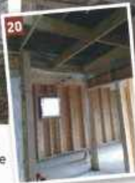
19 & 20 - Des bandes d'étanchéité à l'air ont été disposées par le charpentiers en anticipation du travail du plaquiste.
