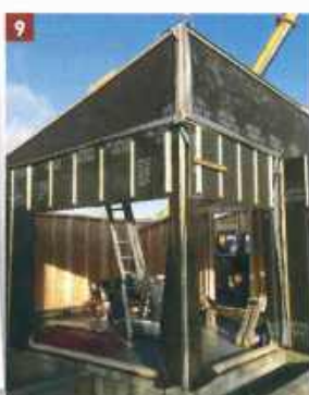
8 & 9 - Le pare-pluie a été appliqué sur les panneaux de bois. Son rôle est de former une enveloppe de protection pour la maison, face à l'humidité. Il sera plus tard recouvert du bardage.
