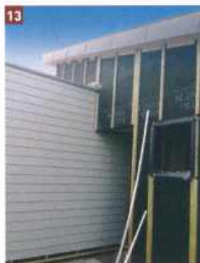
13 & 14 - Avec ses trois corps de bâtiments enchâssés, la maison présente une architecture originale. On observe ici le corps central recouvert du pare-pluie, tandis que le bardage est déjà fixé sur l'espace voisin.
