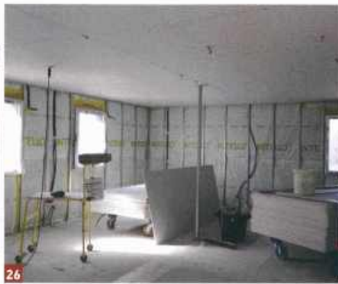
25 & 26 - Le railage a été mis en place au plafond et sur les murs intérieurs : le plaquiste commence à poser les plaques de plâtre au plafond.
