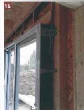
15 & 16 - Les ouvertures sont préparées à l'avance, dans les panneaux de bois. On procède maintenant à la pose des portes-fenêtres. Les pattes de fixations sont mises en place sur l'encadrement de bois.
