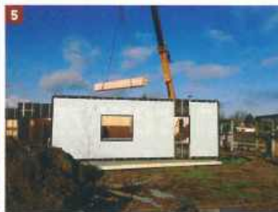
4 & 5 - Le montage de la maison peut démarrer. Les murs et la charpente sont livrés sur le chantier par le charpentier, qui les a fabriqués en atelier selon les plans de l'architecte. Certains panneaux sont déjà dotés de leur parement et sont prêts à être installés.
