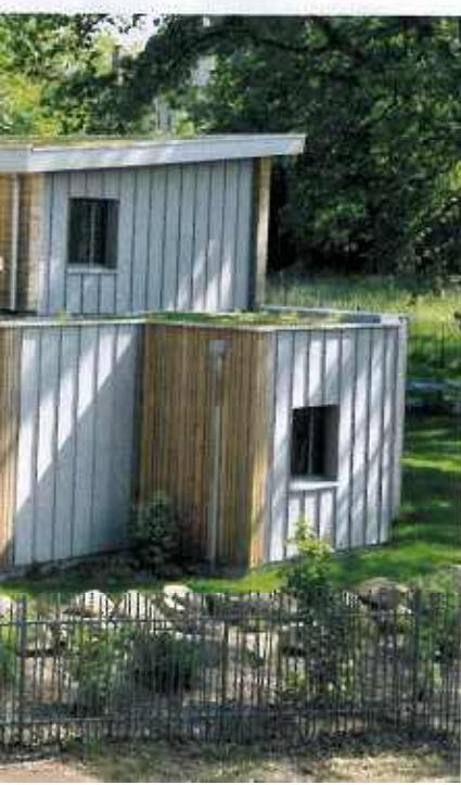
Au nord, la façade paraît encadrée de volumes de plain-pied qui abritent des pièces techniques (garage à vélos, atelier...), ainsi qu'une chambre d'amis. Plates ou monopente, les toitures sont végétalisées (ép. 22 cm), ce qui contribue à l'inertie thermique et au confort acoustique de la maison. Le portail coulissant motorisé est prolongé d'une clôture barreaudée de manière irrégulière («Oobamboo™» de Normaclo).
