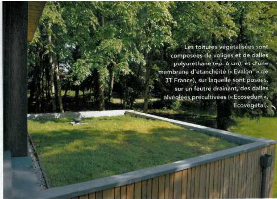
Les toitures végétalisées sont composées de voliges et de dalles polyuréthane (ép. 6 cm), et d'une membrane d'étanchéité (« Evalon » de 3T France), sur laquelle sont posées, sur un feutre drainant, des dalles alvéolées précultivées (« Ecosedum », Ecovégétal).
