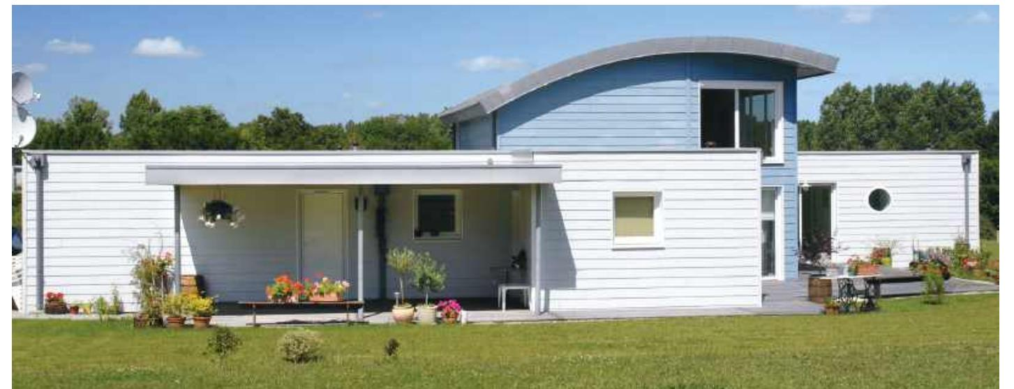
Orientée au sud sur un terrain de 2 000 m<sup>2</sup>, la maison de M. et Mme Mangin se démarque par son allure contemporaine et son « champignon bleu » central. Zinc, bois et aluminium y font bon ménage. La toiture cîntrée est en zinc, posée sur une volige, elle-même posée sur des pannes (des poutres maîtresses). Sur le reste de la toiture plate, ce sont des membranes en PVC. Le bardage, lui, est en fibre et en ciment, peint en usine.
