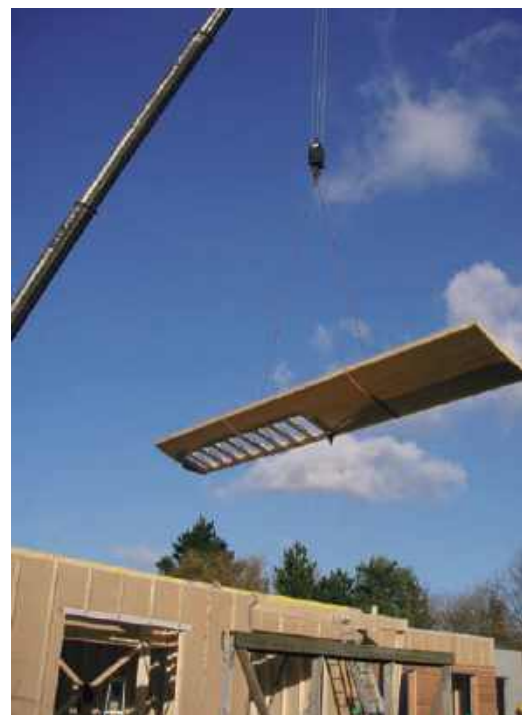
La performance d'isolation de la maison de Patrick repose sur sa structure même. Il s'agit d'une ossature bois en panneaux.
