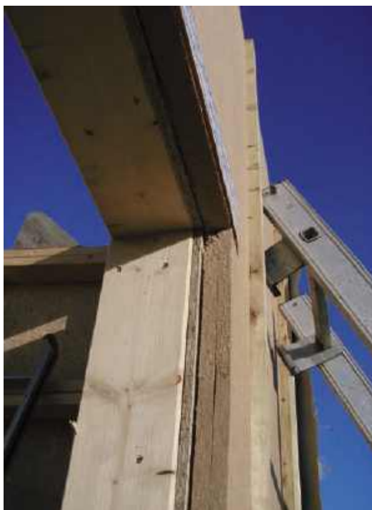
L'enveloppe de la maison est ici renforcée grâce à l'isolation extérieure (fibre de bois de 40 mm d'épaisseur).
