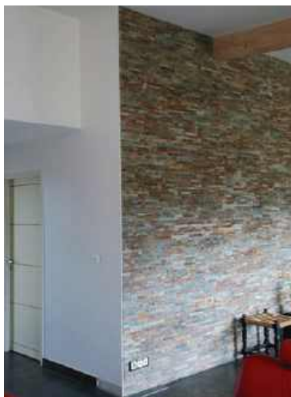
Un mur de masse (parpaings pleins) situé dans le séjour emmagasine la chaleur pour la restituer ensuite.
