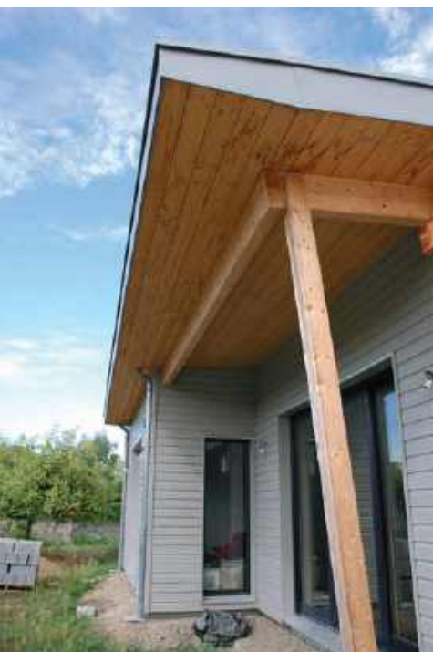
Le débord de toiture n'a pas qu'une fonction esthétique. Il est une protection solaire efficace pendant l'été.
