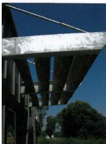
Le confort d'été est assuré par des brises soleil.
