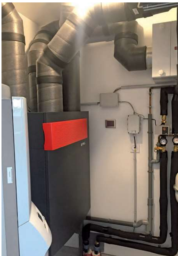
Côté équipements, la maison est dotée d'une VMC double flux couplée à un puits canadien hydraulique et d'un chauffe-eau solaire.
