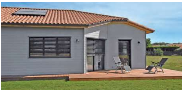
Côté équipements, la maison est dotée d'une VMC double flux couplée à un puits canadien hydraulique et d'un chauffe-eau solaire.
