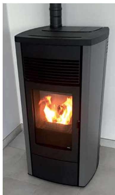
Un poêle à pellets a été installé pour respecter la RT 2012 mais il ne s'avère pas nécessaire vu l'isolation renforcée de la maison.
