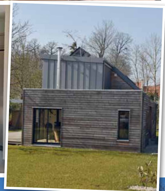
La réglementation thermique (RT 2012) impose un minimum de surfaces vitrées au sud, afin que l'éclairage et le chauffage soient en partie assurés naturellement. Le jeu de matériaux bois/acier vient rompre l'effet linéaire de la construction. Un effet accentué par le fait que le bardage en mélèze est posé horizontalement alors que la vêture aspect zinc est à façonnage vertical.
