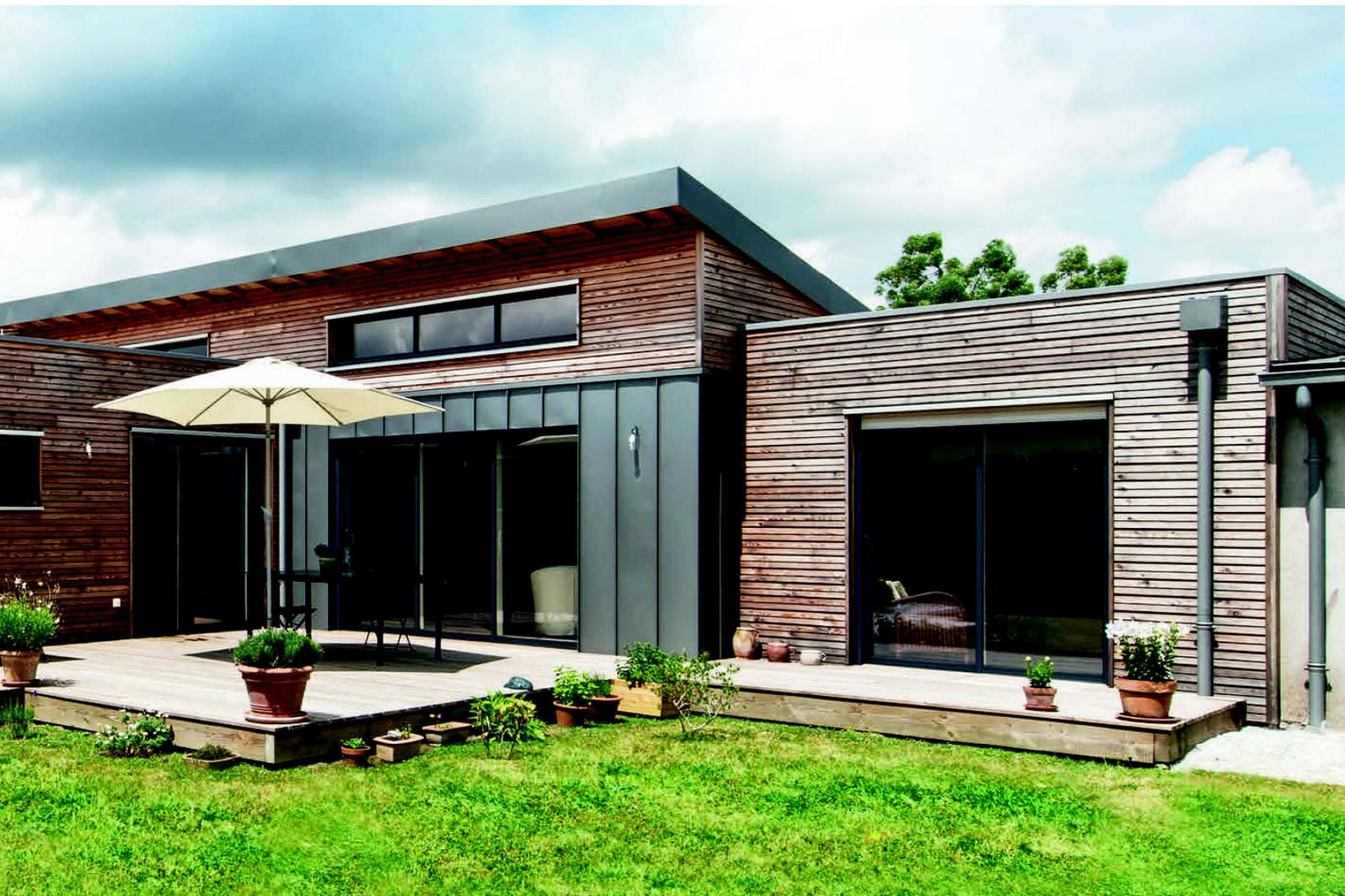
L'ossature bois préfabriquée en atelier et certifiée PEFC (bois issus de forêts gérées durablement) et un bardage mixte mélèze/bac acier distinguent les blocs d'habitation tout en les solidarisant. Une réalisation des Charpentiers de l'Atlantique (L.C.A. Groupe Bonnin Charbonneau) et Tallof Couverture.
