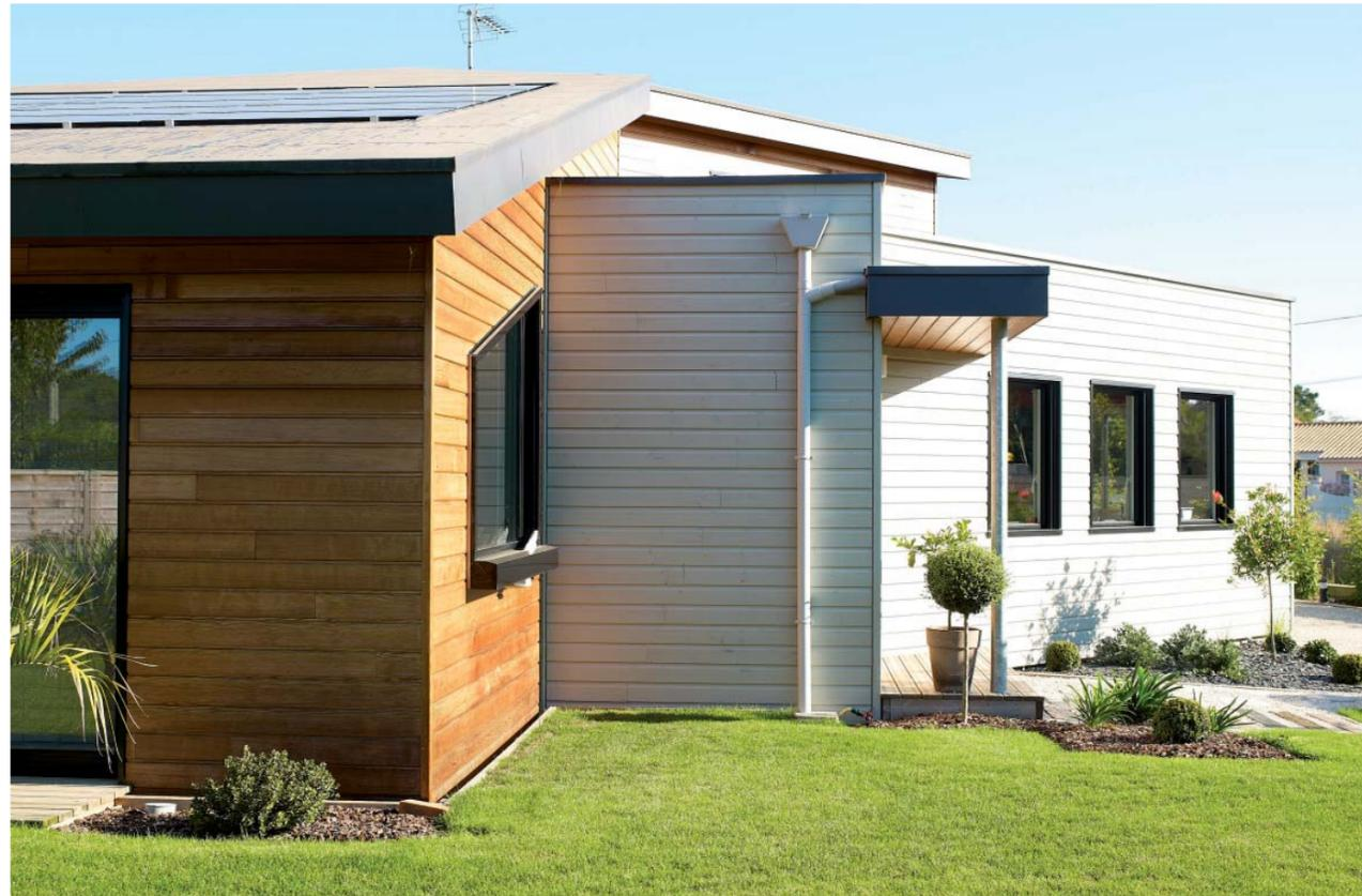
La couverture de la maison comprend un toit mono-pente et des toitures-terrasses végétalisées. Les pentes accueillent les panneaux photovoltaïques et thermiques.
